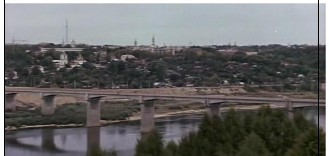
Вид с правого берега, строится небольшой участок набережной
